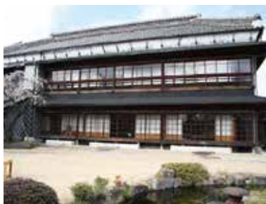
豪壮な建物全景。木造2階建・寄棟・瓦葺き・土蔵造り。延床面積は415.52㎡。
