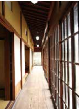
廊下の梁に使われている杉材は長さ17.5m。端から端まではほぼ同じ太さです。ガラスも建築当時の物。
